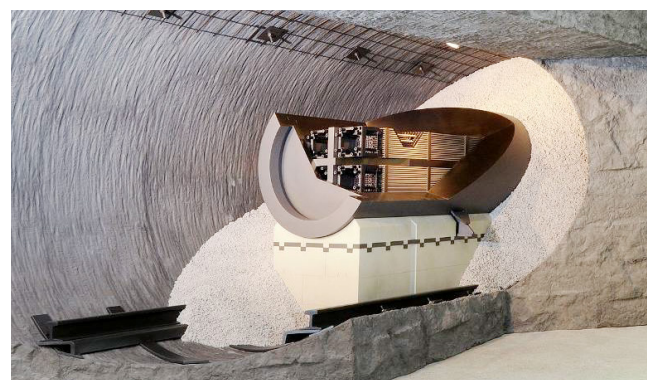
図1 スイスの高レベル放射性廃棄物処分コンセプト。グリムゼル試験場の実物大模型
