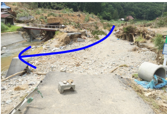
写真1 集中豪雨による河川氾濫流と河岸浸食 (2018年7月兵庫県宍粟市公文地区)
