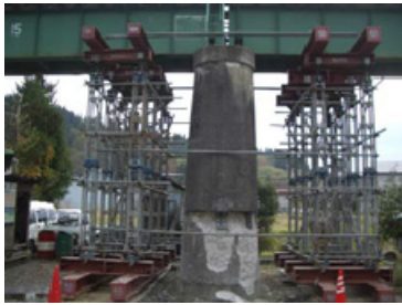
写真-2 魚野川橋梁14P橋脚 1) (左が北東, 右が南西方向)
