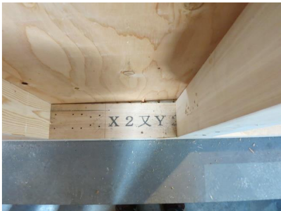
e) 合板間柱部のパンチアウト 試験体 PW, 加振 No.5 後
