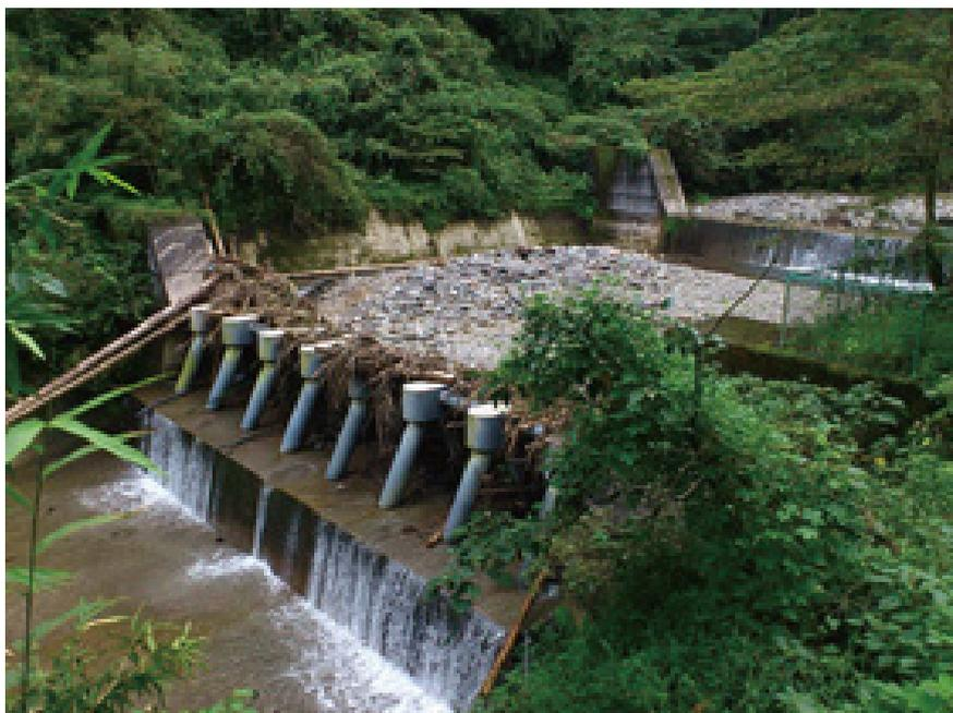
写真-2.1 不透過型砂防堰堤の前庭部（副堰堤）における一般的な流木捕捉工<sup>4)</sup>
