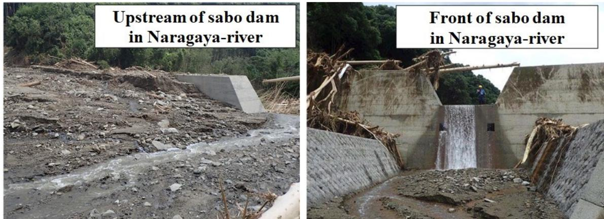
図-1.2 山の神ため池の更に上流における不透過型砂防堰堤の捕捉状況（被災直後）
