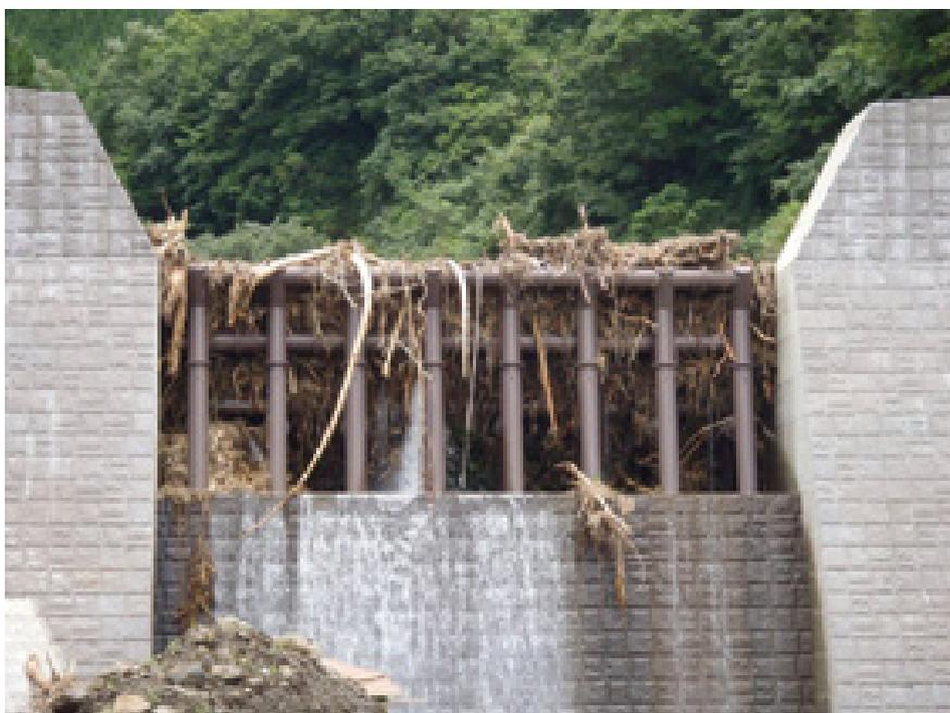
写真-2.2 不透過型砂防堰堤と鋼製透過型部材を併設させた一般的なハイブリッド構造（部分透過型砂防堰堤）<sup>4)</sup>
