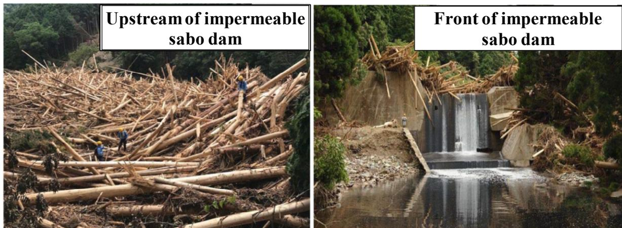
図-1.4 災害後における不透過型砂防堰堤（妙見川：須川第一砂防堰堤）の流木捕捉状況<sup>8)</sup>
