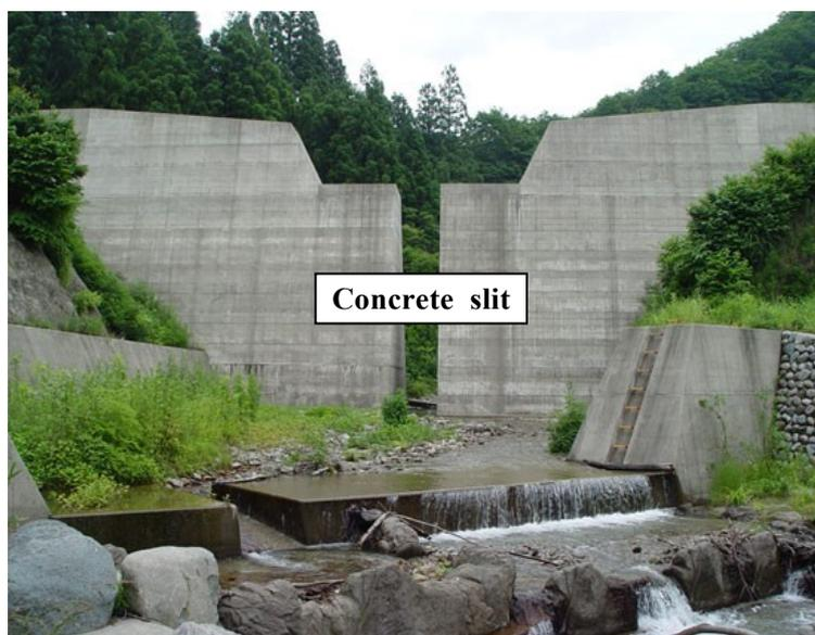
図-3.1 掃流区間における一般的なコンクリート・スリット堰堤
