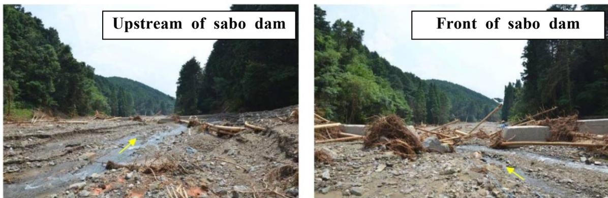
図-1.3 その他の流域で被害を受けた上流における不透過型砂防堰堤の捕捉状況（被災直後）
