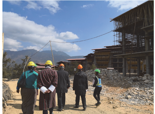
写真2 法学校建築現場の見学風景
