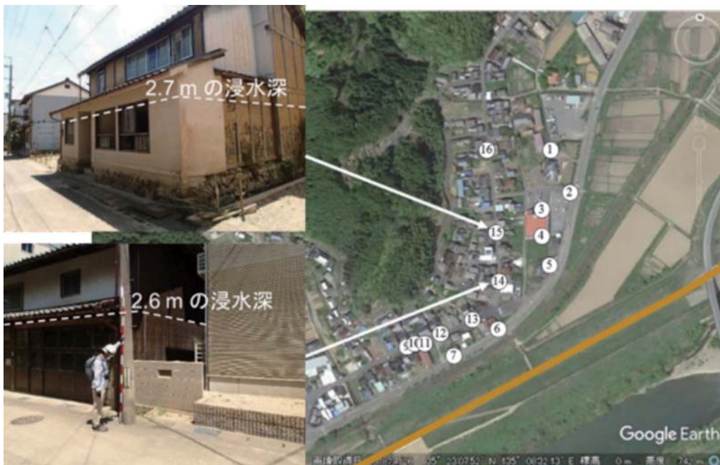
蓼原川樋門等の閉鎖により浸水した福知山市蓼原地区・河守地区の住宅地
