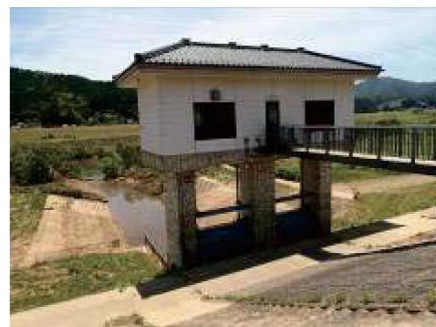
図-3 蓼原川樋門
