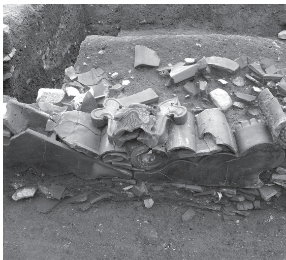
4 SX6エリア2の鬼瓦出土状況（北から）
