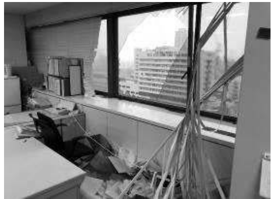
図 24 窓ガラスの破損によるビル室内の被害
