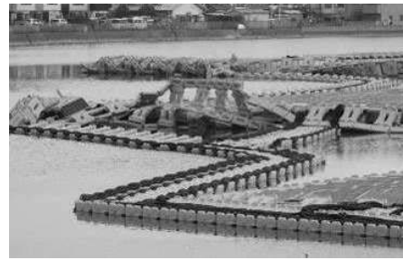
図 40 水上設置型太陽光発電システム設備の被害
