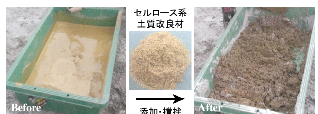
図2 セルロース系土質改良材による高含水泥土処理
