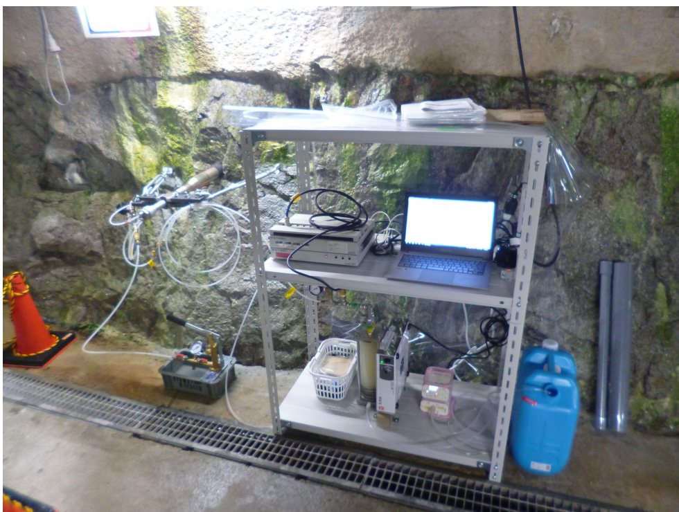
図5 原位置岩盤透水試験装置
