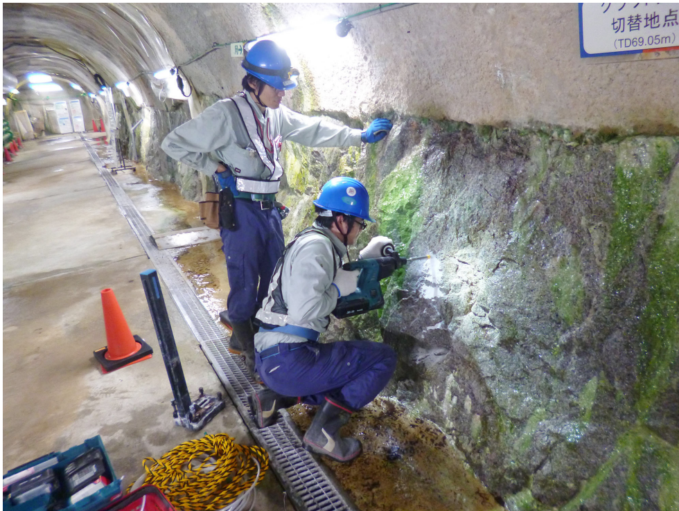
図4 原位置岩盤での透水試験装置設置作業の様子
