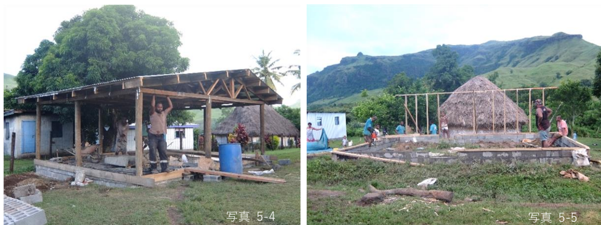
写真 5-4 及び写真 5-5 ナバラ村における新建材住宅の建設
