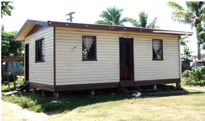
写真 3-3 エバン被災後に再建された住宅
