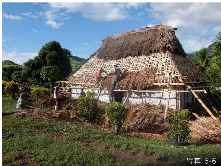
写真 5-6 及び写真 5-7 共同労働によるブレの屋根の葺き替え
