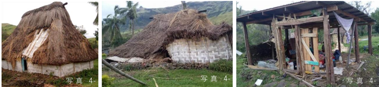
写真 4-11 及び写真 4-12（左，中） ウィンストンにより損壊したブレ 写真 4-13（右） ウィンストンにより被害を受けた新建材住宅（出典：Ba Office）
