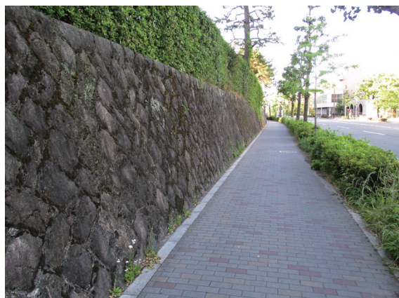
写真① 本部構内東大路沿いの石垣。北側より東一条交差点方向を見る。
