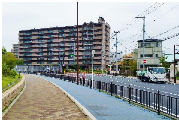
Fig.5-18 歩道と自転車道の分離 (執筆者撮影, 茨木市岩倉町)
