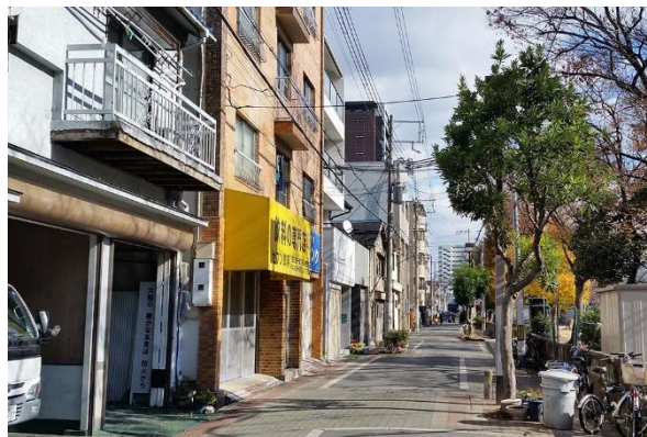
Fig. 5-19 幅員 6m 道路におけるコミュニティ道路 (執筆者撮影, 大阪市関目町)
