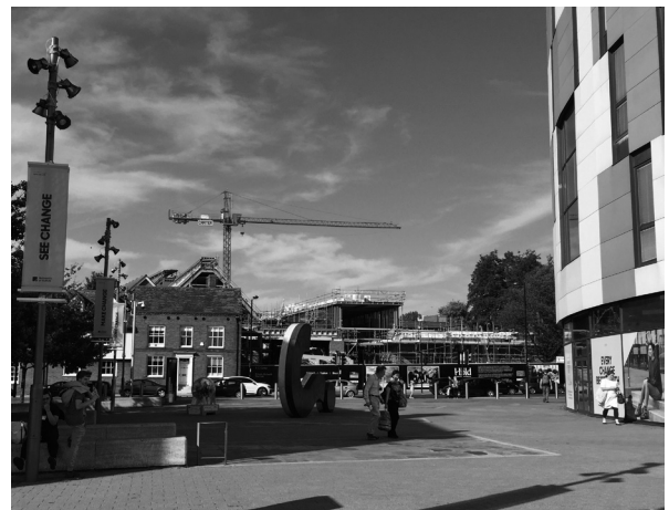
図3 イプスウィッチ・ウォーターフロントに位置するUOSビル（右）と建設中のThe Hold（UOSの左奥）（筆者撮影：2019.08.21）
