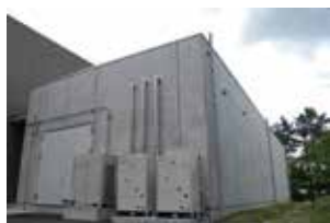
2004年6月に竣工した高強度レーザー科学棟
