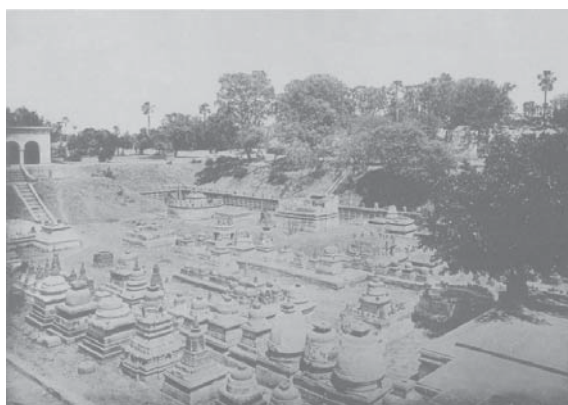
圖 11 奉獻塔區 (舊狀) ボードガヤー
