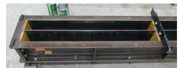
写真-3 コンクリート打設前
