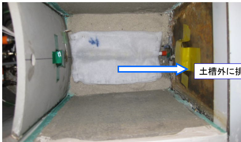
写真-4.16 排水用管の設置状況
