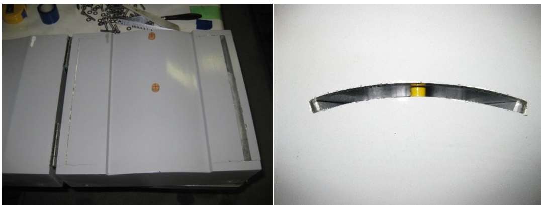
写真-4.3 インバートの型枠への開孔
