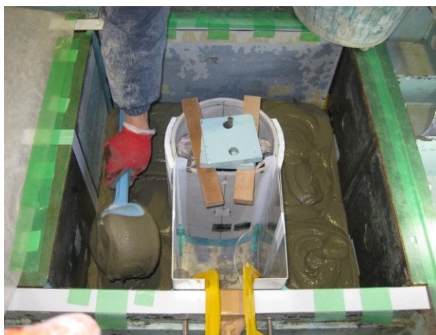
写真-4.12 低強度モルタル打設の状況
