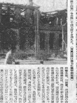
薬学部研究資料の焼失現場 (東京六大学連合会提供)
