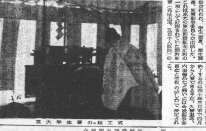
新学生寮の第一期工事に着手
