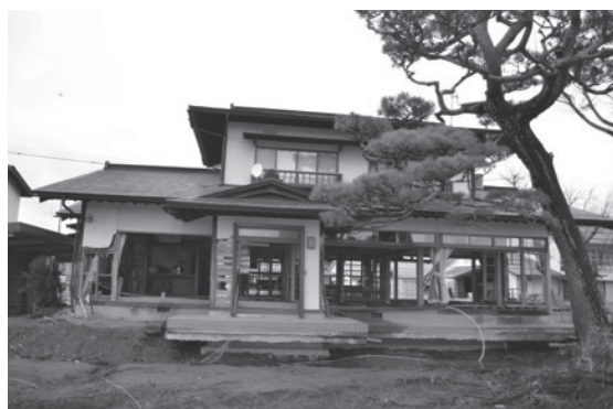
(a)大破した2階建木造住宅③
