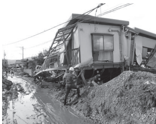
(c)住宅⑦(大破して流出した2階建て鉄骨造住宅, 1階はピロティ形式)
