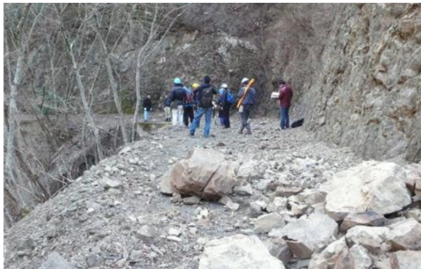
写真1. 崩壊した和歌山研究林の林道の様子 (2013年3月11日文科科学省による実地踏査)
