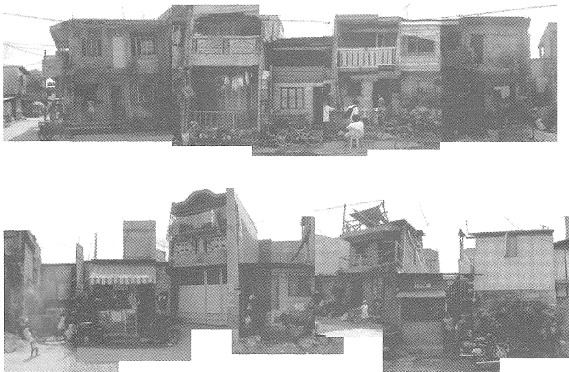
写真1 RC Framed Masonry (フィリピン)
