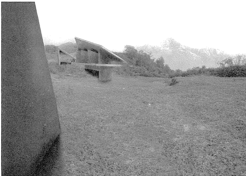
2. エントランスタワー内部のロビーから客室とマチャブチャレを望む。
