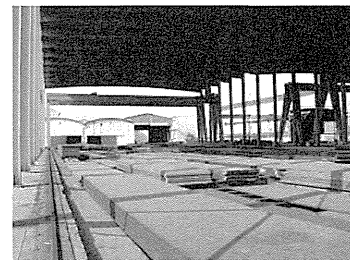
(a) 厚板ストックヤード
