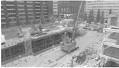
写真5：大手町1-1計画A棟新築工事現場
