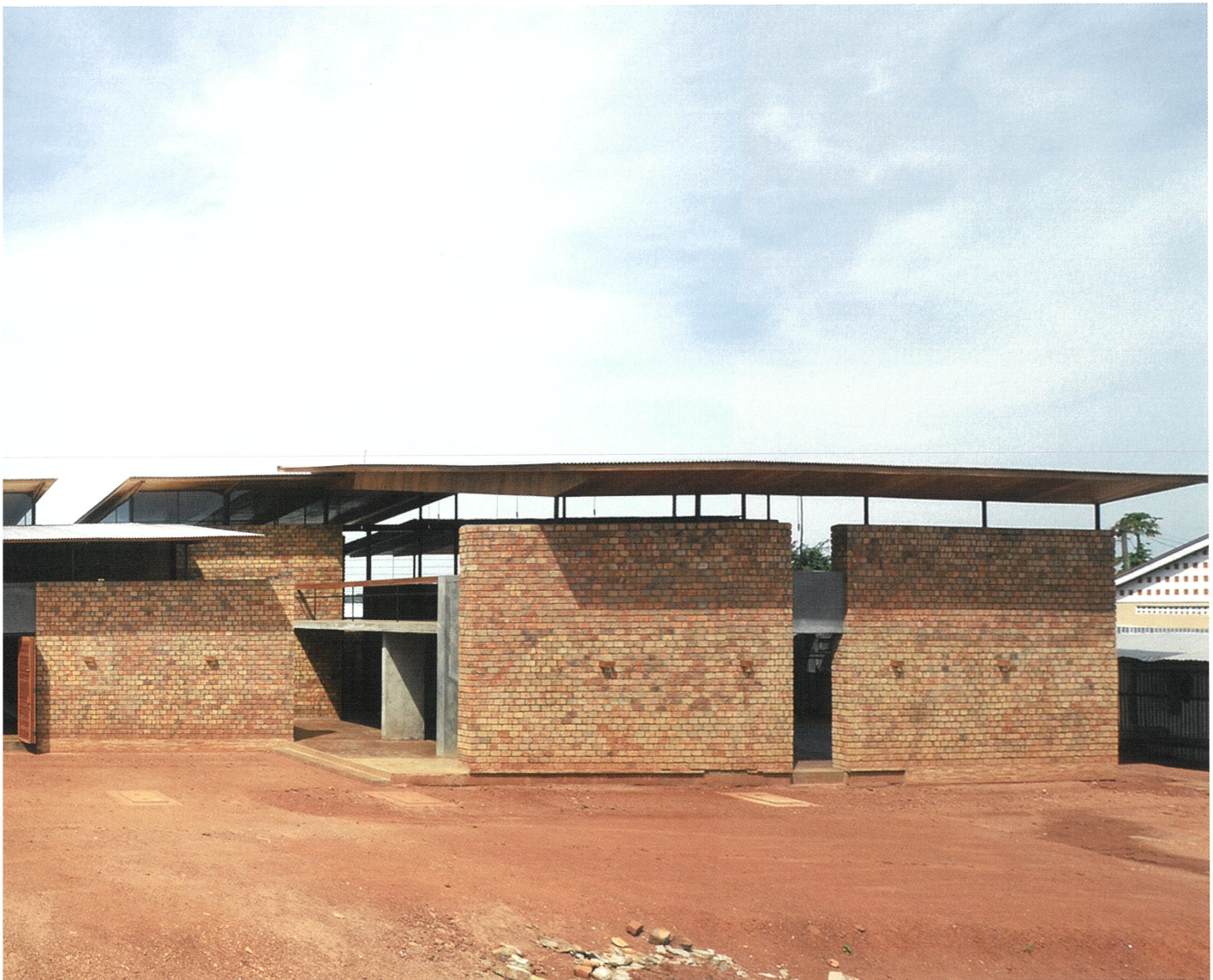
「AU dormitory」(第一期工事後)
