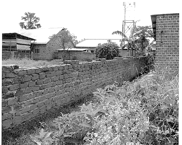
敷地周辺にあるレンガ造の構造物
