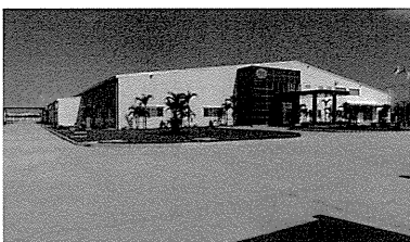
図5 M工場外観
