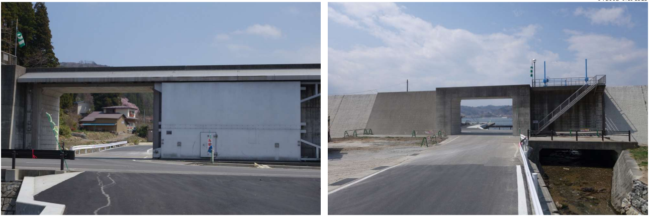
写真6、7 津波ゲート・コミュニティ（岩手県宮古市堀内地区）
