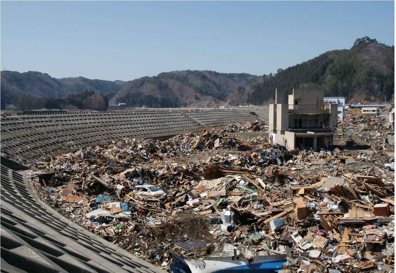
写真3 岩手県宮古市田老地区の被害
