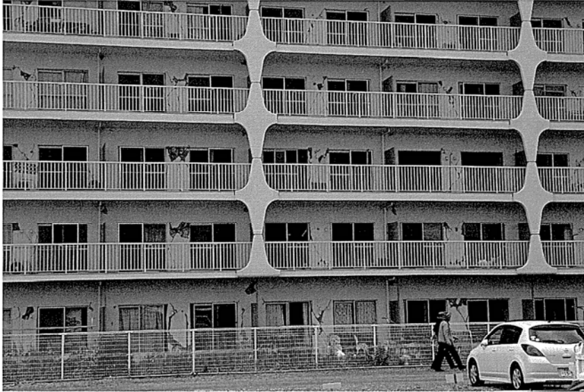
写真2 震災後、取り壊されたマンション（牧紀男撮影）
