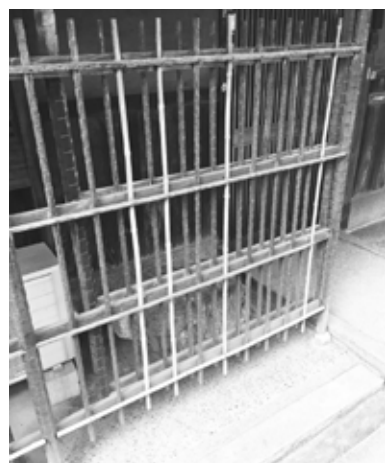
民家の木製格子。朽ちて無くなった部材を同径の竹で補う。部材寸法の共通性が異素材をブリッジする。
