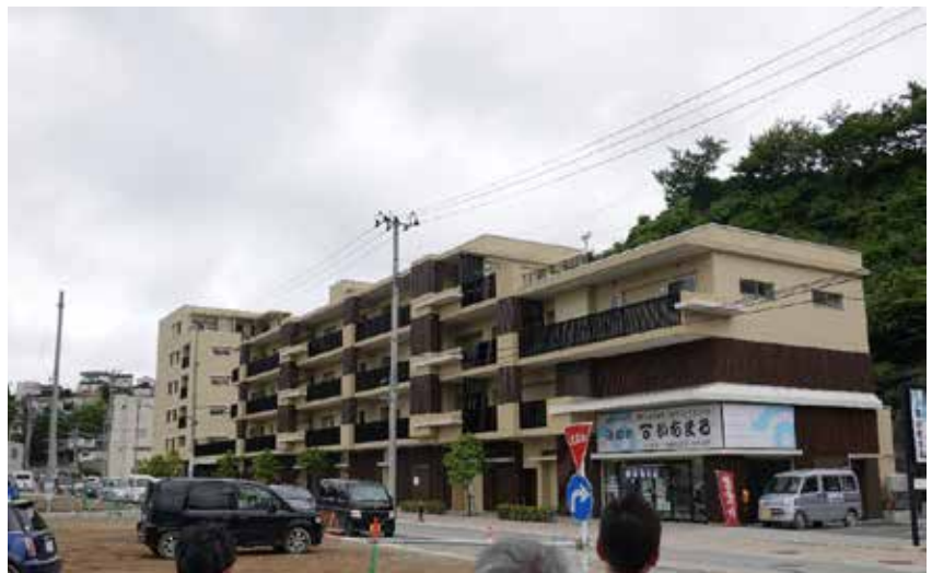
写真7 気仙沼内湾地区の下駄ばき災害復興公営住宅
