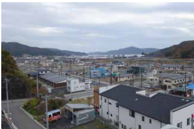
写真1 岩手県大槌町町方地区(盛土の上に新たな住宅地が建設される)
