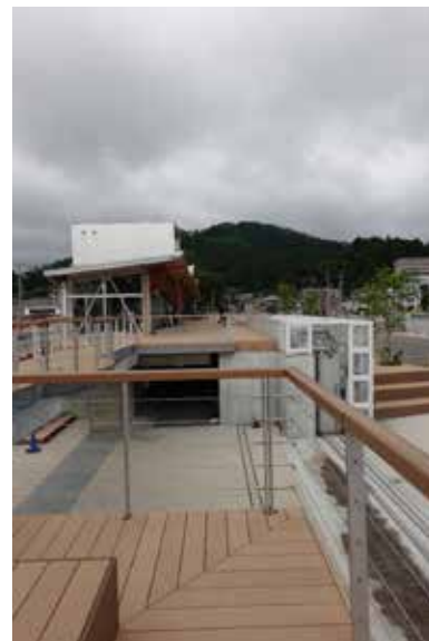
写真5 堤防と一体となった建築物（気仙沼「迎（ムカエル）」）
