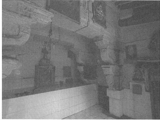
図38 マングロールの南門、現状はヒन्दウー祠堂、北東より撮影
