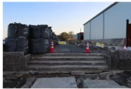
幸浦の護岸復旧状況②
