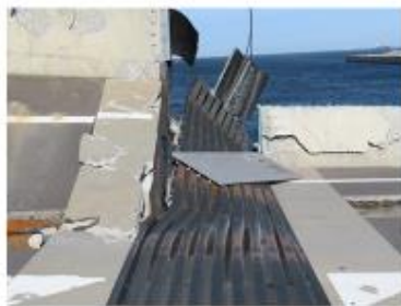
PC栈橋と箱桁橋の接合部分
