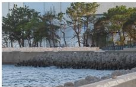
幸浦の護岸復旧状況①
