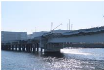
PC栈橋と箱桁橋の接合部分①
