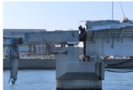
PC栈橋と箱桁橋の接合部分②
