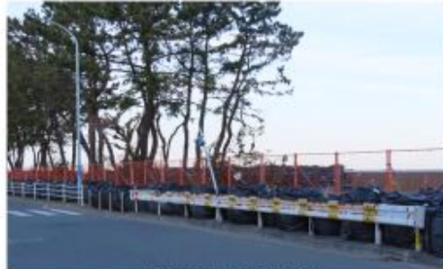
福浦の護岸復旧状況
