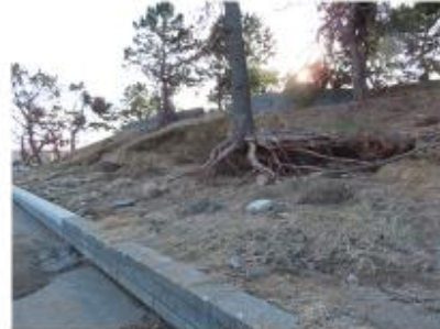
福浦の護岸沿い築山
