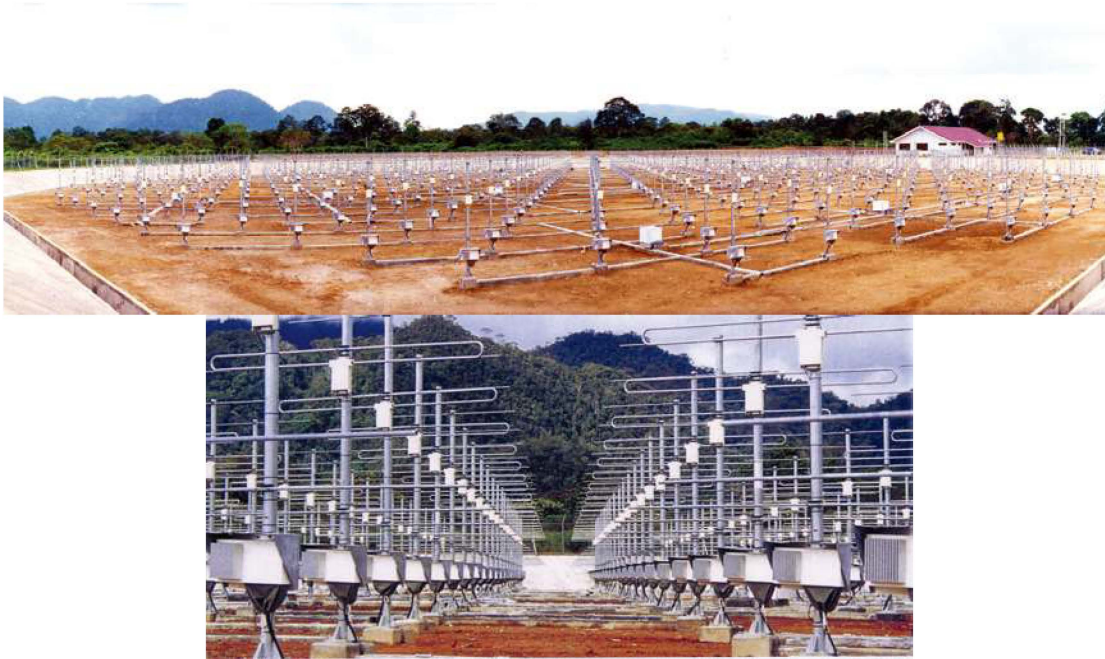
図 5 赤道大気レーダーの全景(上図)及びアンテナ近景(下図)
