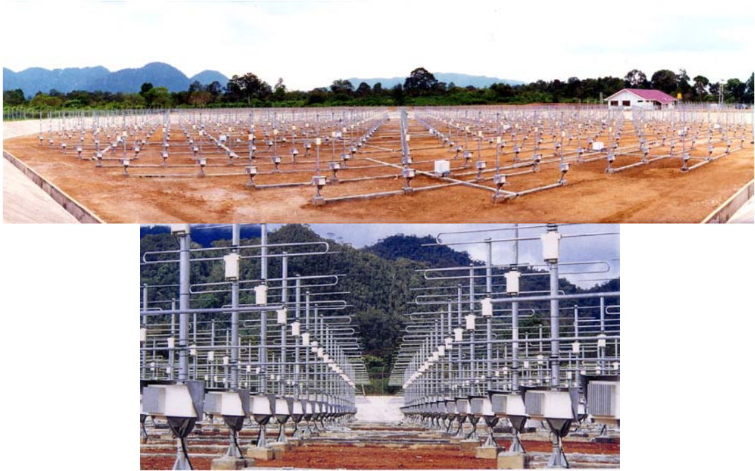
図 2.6 赤道大気レーダーの全景(上図)及びアンテナ近景(下図)
