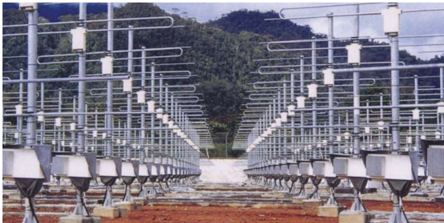
赤道大気レーダー：直径110 mの巨大アンテナが560本の八木アンテナから構成される。
