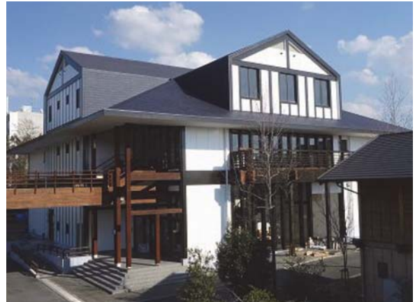
木質材料実験棟
