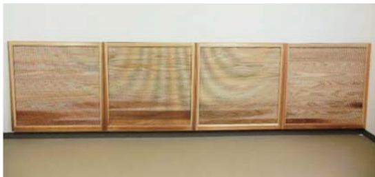
図 6-3：スギ木口スリット内装パネル
