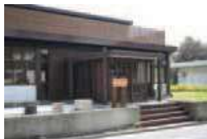
材鑑調査室工事後の外観
