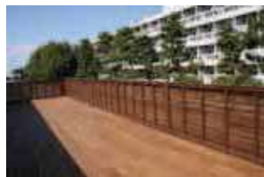
二階ウッドデッキ
