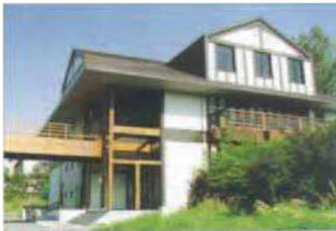
写真1 木質材料実験棟全景
