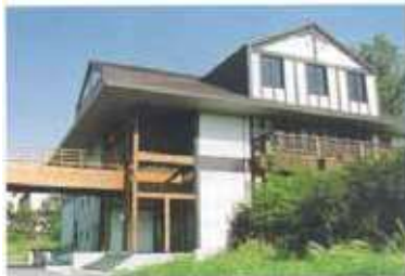
写真1 木質材料実験棟全景
