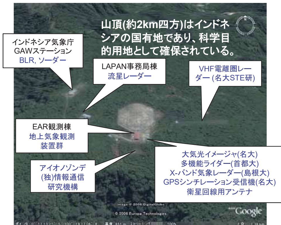
図2 赤道大気レーダー（中央）を含む観測所全景と観測装置群
