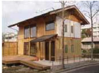
写真2 実験住宅「律周舎」
