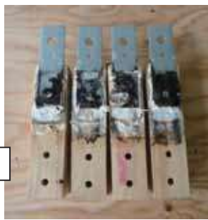
写真 2 腐朽処理後の例
