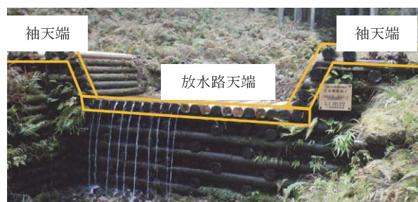
写真7 木製治山ダム
