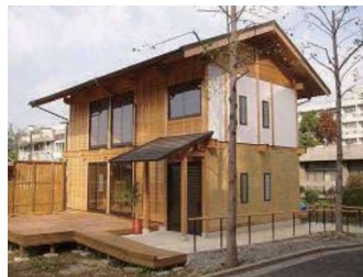
写真2 実験住宅「律周舎」
