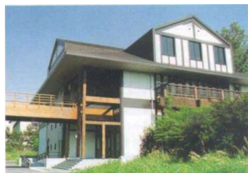
写真1 木質材料実験棟全景
