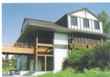
写真1 木質材料実験棟全景
