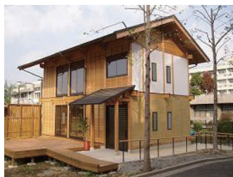
写真2 実験住宅「律周舎」
