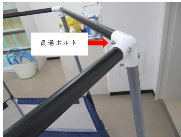
写真 4 : 各パイプの接続部
