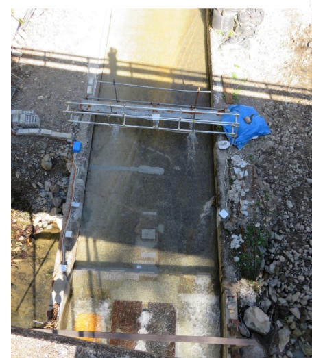
写真4. 全工事完了後
