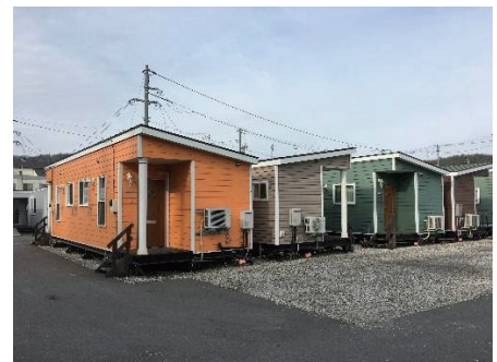
写真3 トレーラーハウス型仮設住宅 (岡山県倉敷市)
