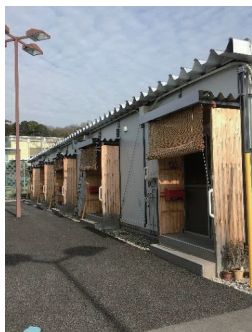
写真1 軽量鉄骨造の仮設住宅 (岡山県倉敷市)
