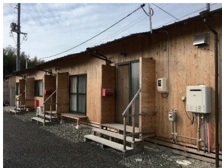
写真2 木造の仮設住宅 (岡山県倉敷市)
