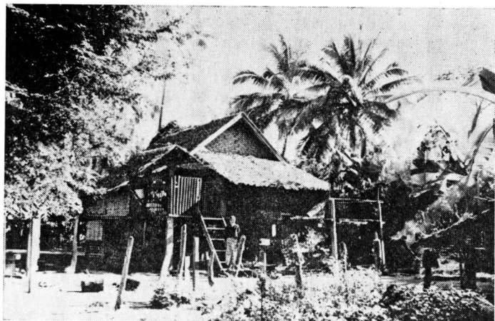
写真16 平地カレン族の家屋、家の周囲には、 レ 田い込み、 ル すら始めている。
