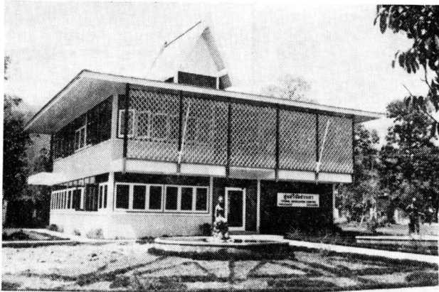
写真32 Chiangmai 大学の一隅に設立された Tribal Research Centre
