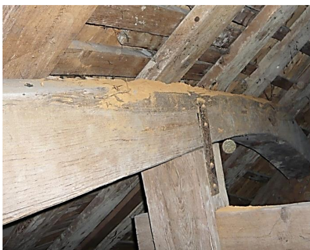
図 2-29 チビキノコシバンムシ被害の様子
