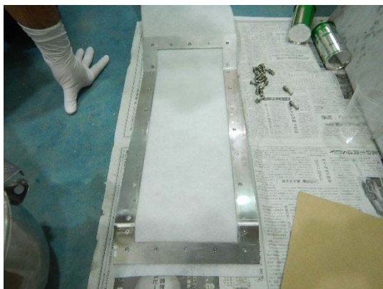
(手順1) 布材（下面）に型枠を設置.
