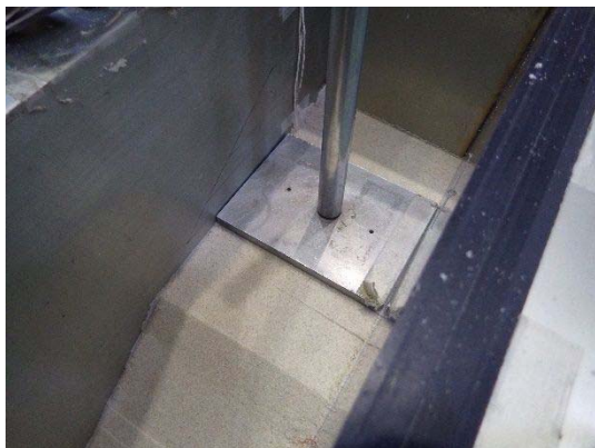
(⑤締固め棒による締固め状況)
