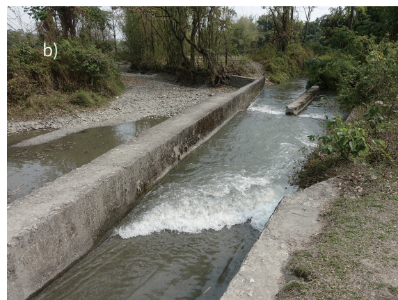
図6 井堰 (a) と灌漑水路ダウン (b)
